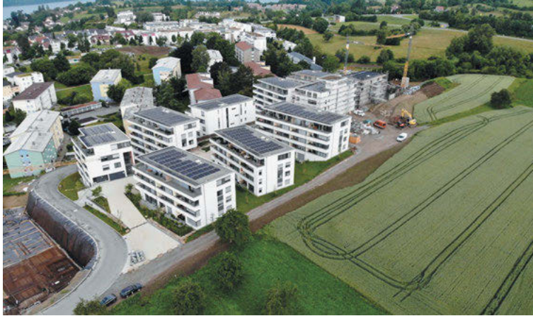
Figure 31.3: The demonstration district in Überlingen, (source: Baugenossenschaft Überlingen (2021)).
